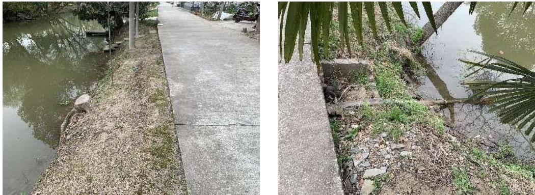
图 7 道路东侧部分河坡塌方现状图。
